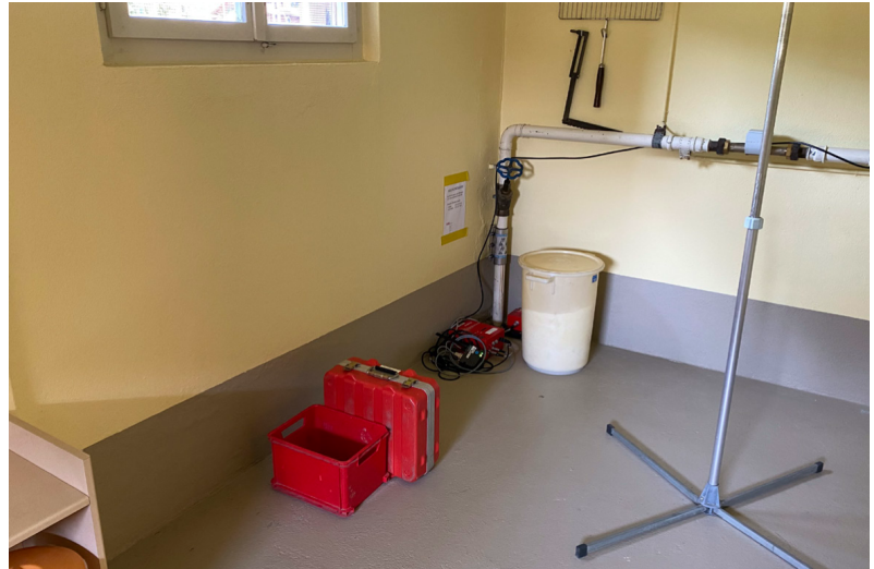
Erschütterungsmessgerät in Gebäudekeller Übersicht
