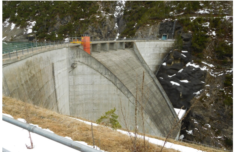
Kraftwerk Ova Spin (in Staumauer integriert)
