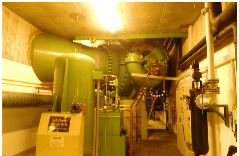
Kugelschieber (vor der Revision)
