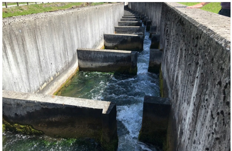
Sanierungspflichtiger konventioneller Schlitzpass
