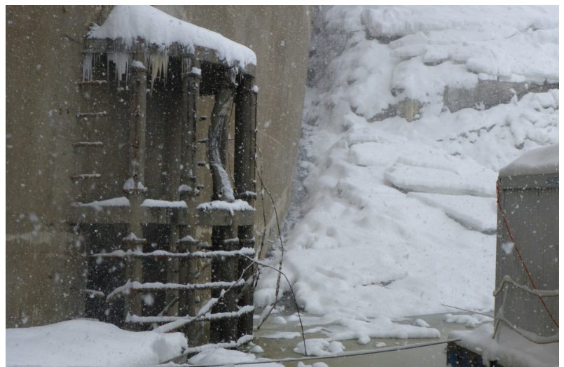
Lavori di demolizione alla presa d'acqua-nell'area di accumulo
