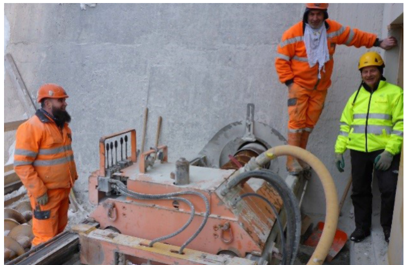
Perforazione attraverso la diga per installare un tubo di scarico dei sedimenti d = 400 \text{ mm} , L = 28 \text{ m}
