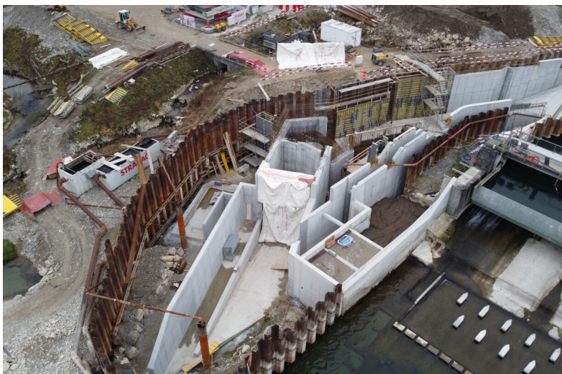
Baugrube Dotierkraftwerk mit Fischauf- und -Abstiegshilfe, Betonarbeiten und Einheben Konus
