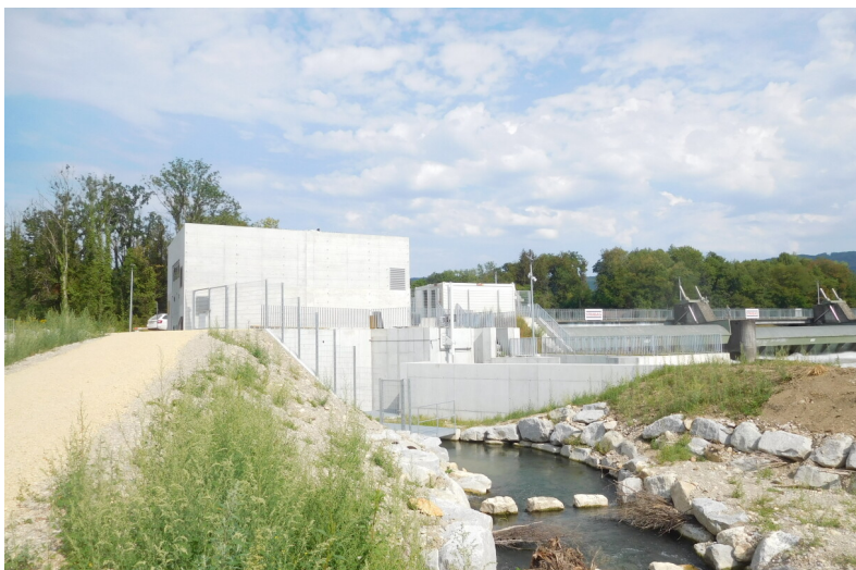
Aussenansicht Dotierkraftwerk UW-seitig mit Fischaufstiegshilfe (Schlitzpass/Raugerinnebeckenpass)
