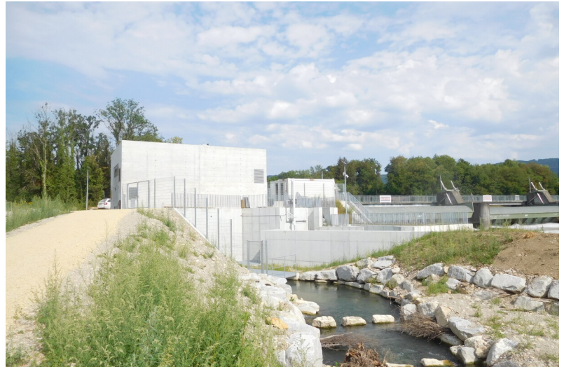
Aussenansicht Dotierkraftwerk UW-seitig mit Fischaufstiegshilfe (Schlitzpass/Raugerinnebeckenpass)
