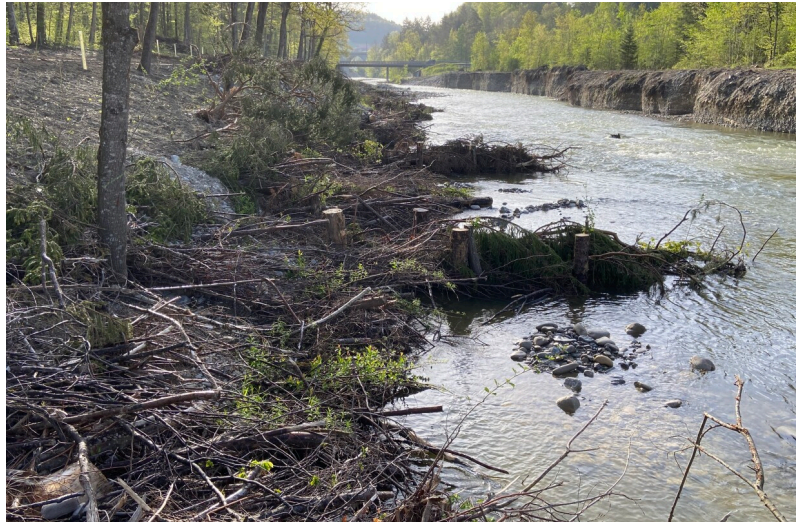
Protection mécanique biogène des rives et arbres en épis sur la rive droite, élargissement sur la rive gauche ; vue contre le sens d'écoulement
