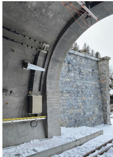
Tunnelfunkanlage
