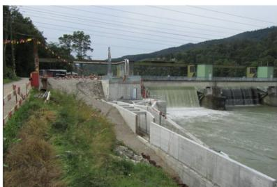
Fertiggestelltes Dotierkraftwerk mit Fisch-Einstiegsgallerie und Vertical-Slot-Fischpass
