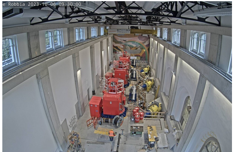
Montage des conduites circulaires et des corps de turbines (photo : webcam du chantier)
