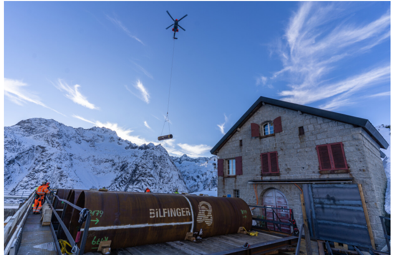
Transport der Rohre mit einem Schwerlasthelikopter
