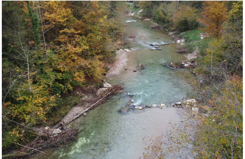
Ein Jahr nach Einbau: Morphologische Diversifizierung durch Blocksteinriegel und ergänzende Strukturmassnahmen
