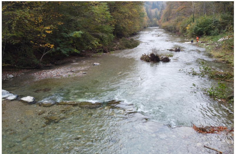
Einbau fischgängiger Blocksteinriegel zur Sohlenstabilisierung
